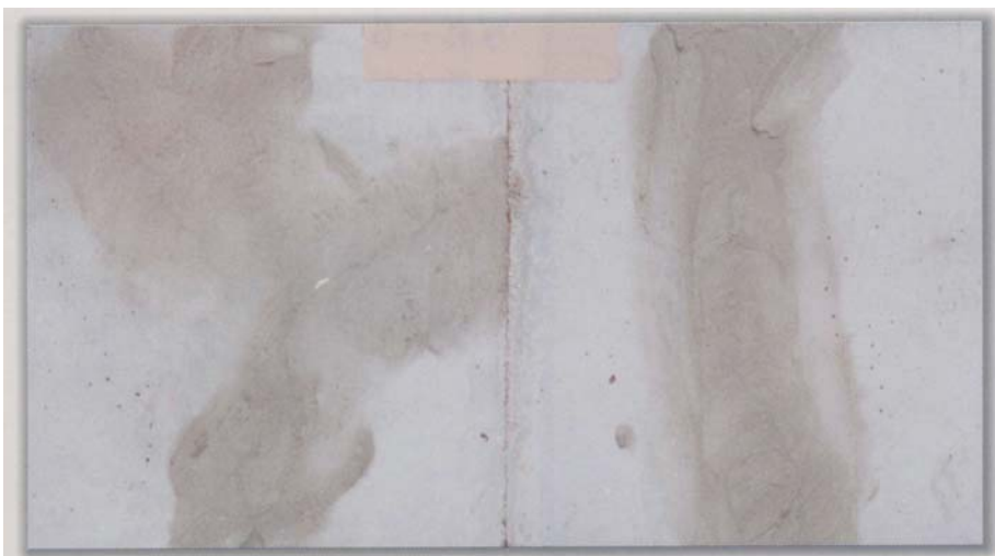
写真 - 3 補修材（セメント+SSS せっこう+補修剤）を補修液で適度な軟度に練り、補修部に手で詰め込む（指先で円を描くように初めは強くし、徐々に軽く詰め込む）
