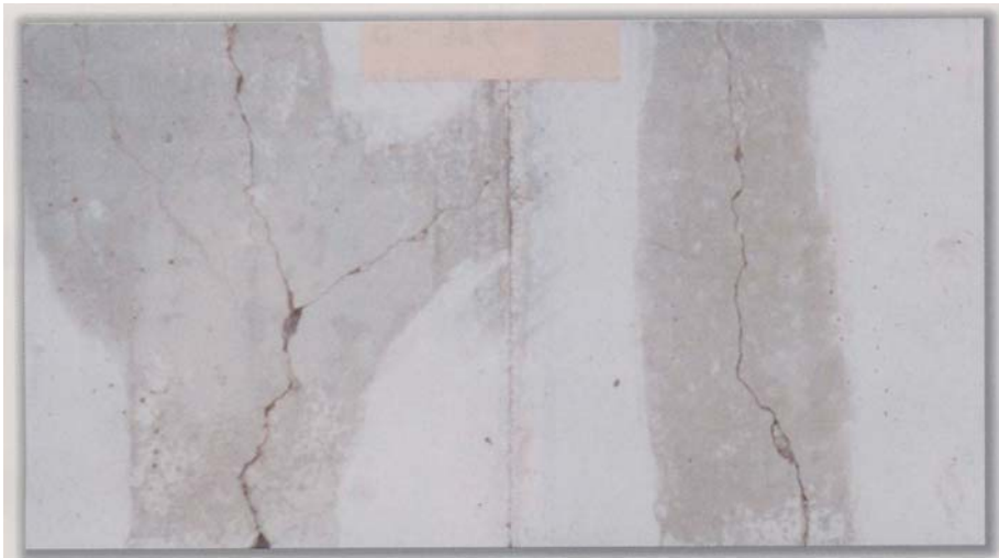
写真 - 2 補修液を補修部に刷毛で入念に塗布する
