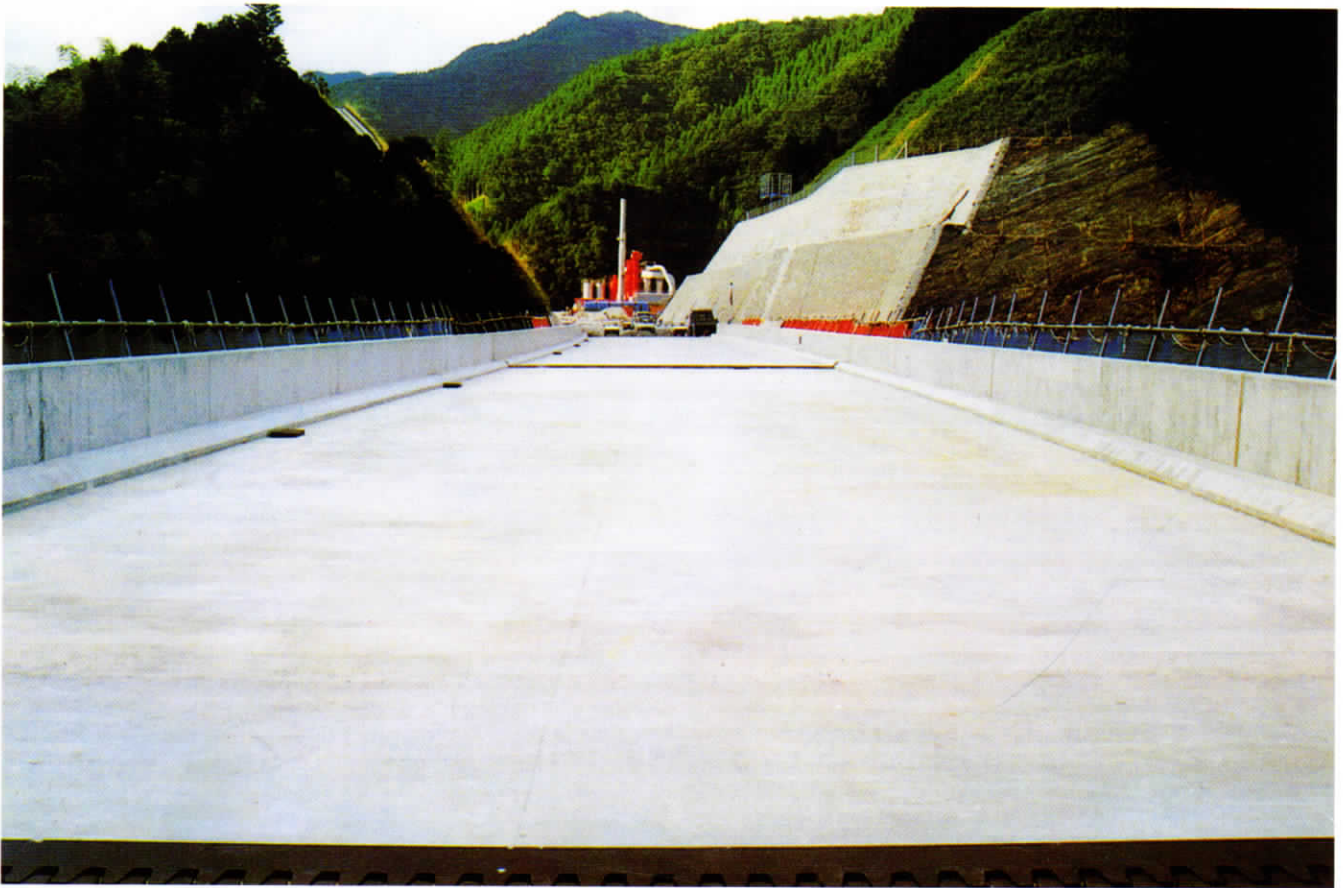
高知大豊線橋梁工事
