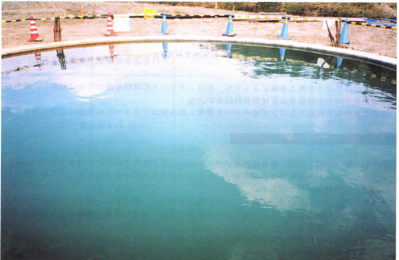
鳥取県河原千代川下部工工事
