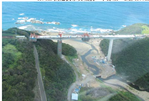
西之表市安城橋 下部工 2基
