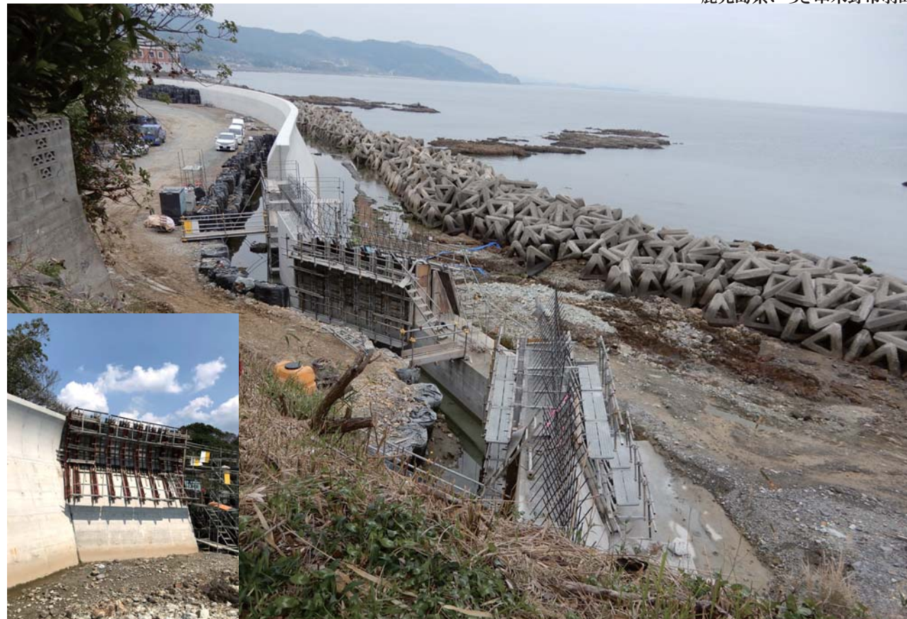
鹿児島県いちき串木野市羽島
