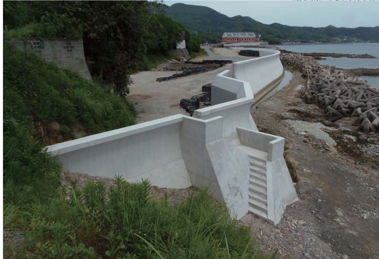
鹿児島県いちき串木野市羽島
